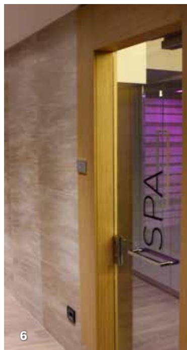
ottimo risultato in termini di assorbimento acustico e, allo stesso tempo, una resistenza al fuoco di 60 minuti.
