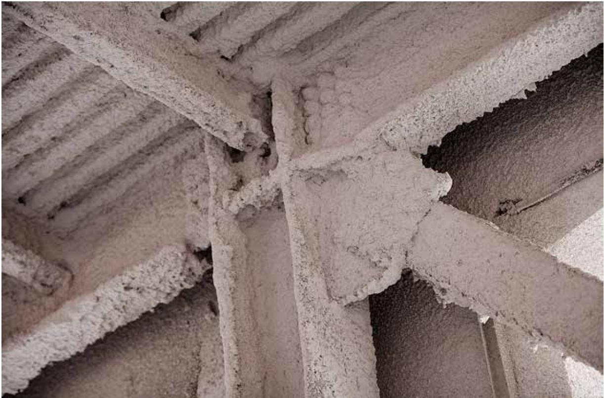
Intonaco per protezione dal fuoco a base gesso con perlite e altri inerti speciali. Knauf MP 75 L Fire è stato sviluppato appositamente per offrire una protezione passiva dal fuoco agli ambienti interni e agli elementi portanti, rivestendoli in modo che restino intatti fino a che l'incendio venga estinto.
